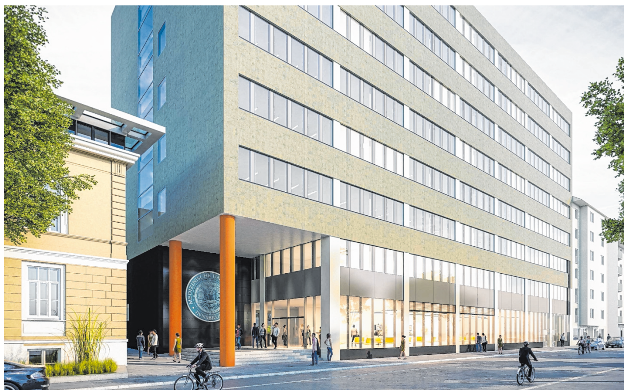
Ein neues Haus für die Studierenden und MitarbeiterInnen: Das ehemalige Laborgebäude wird zu einem der modernsten Lehrgebäude Österreichs umgebaut.
